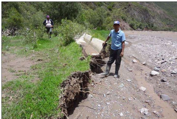
FIGURA N°01: TRAMO CRÍTICO DEL RIO CACHI, SE OBSERVA CANAL DE CONDUCCION INTERRUPTIDA Y AISLADA.
